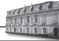
Sous-préfecture de Condom
